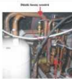
Yüksek basınç sensörü
