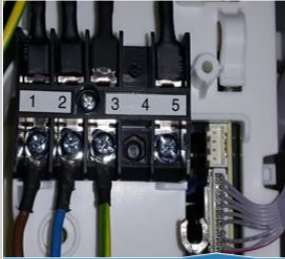
İç ünite terminalinde dış üniteye giden sinyal kablosunu sökün.
